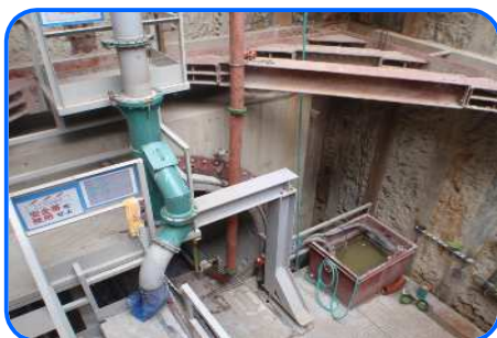
■ コンクリート落下装置
