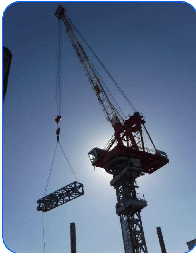
■タワークレーン
