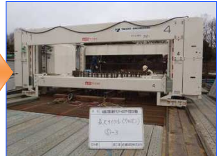
鉄筋かご建込み後
