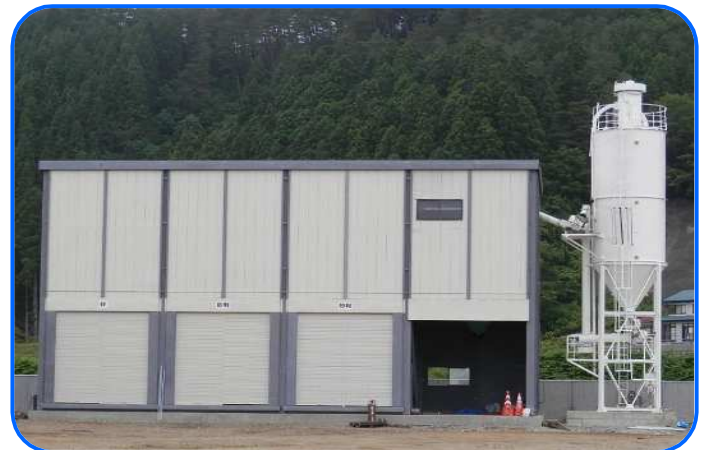
■バッチャープラント
