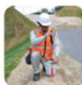
超高速レスポンスの杭打ちナビゲーション
