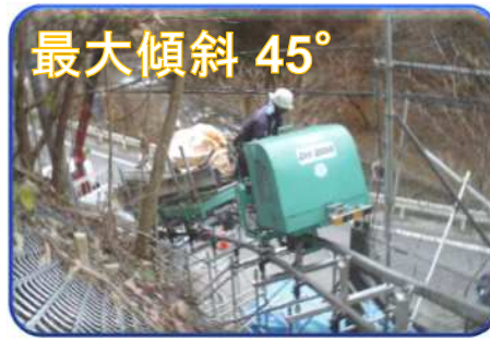
■ 工事用モノレール
